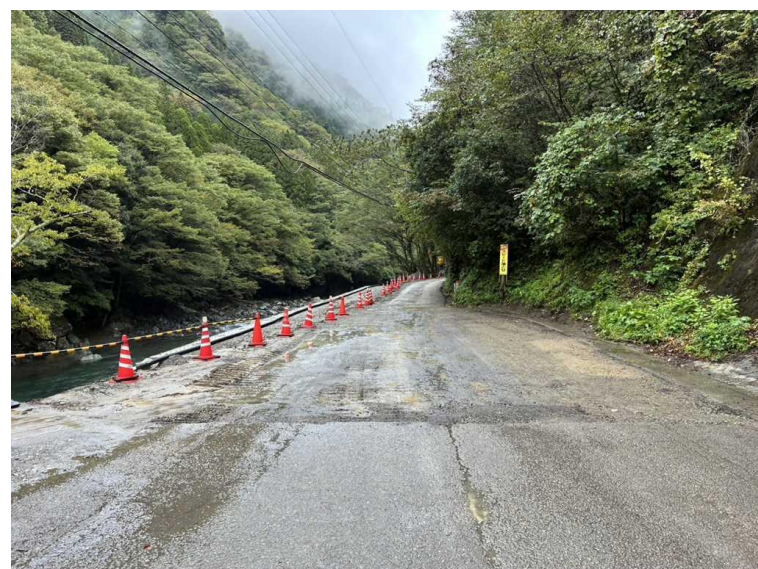
現場写真（終点）
