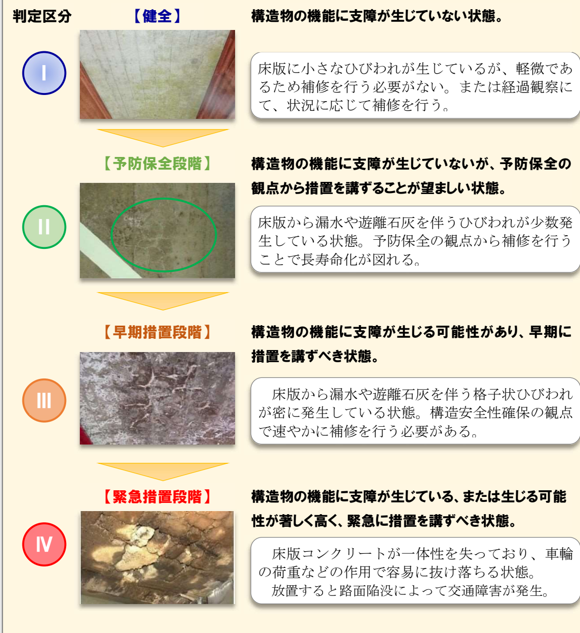
図 13 橋の健全度の事例
