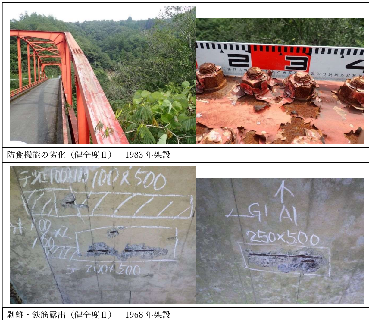
図 5 損傷状況
