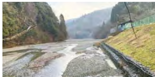
小崎小下堆積土砂の状況
