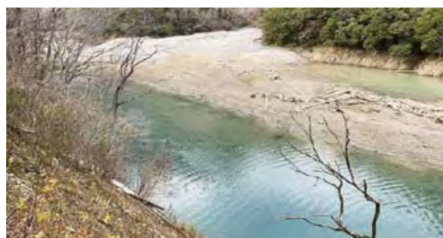
ダムの堆積土砂
