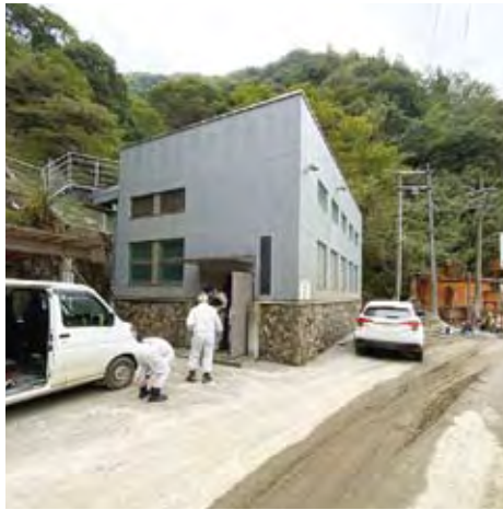
台風14号により浸水した村営発電所
