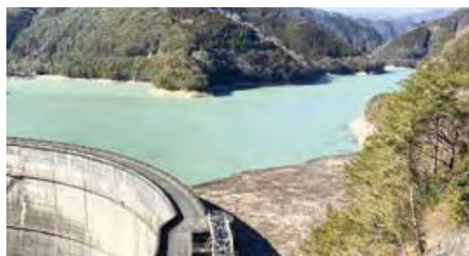
ダム湖の流木浮遊の状況
