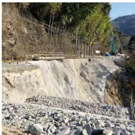
327号松の平国道仮復旧現場
