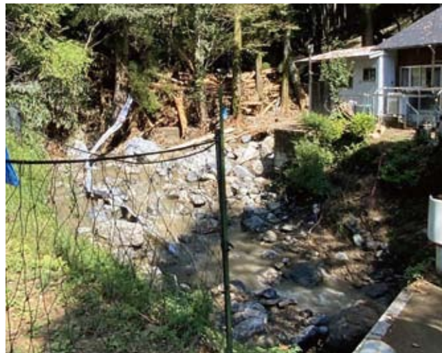
山腹崩壊による流木を辛うじて立木が堰き止めた(仲塔・財木地区)
