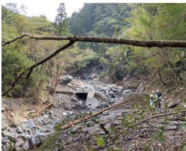
林道渡川大藪線、土石流による大規模道路災害 (大河内・大藪地区)
