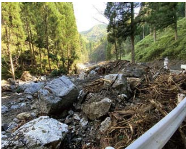
山腹崩壊と土石による道路災害(仲塔・財木地区)
