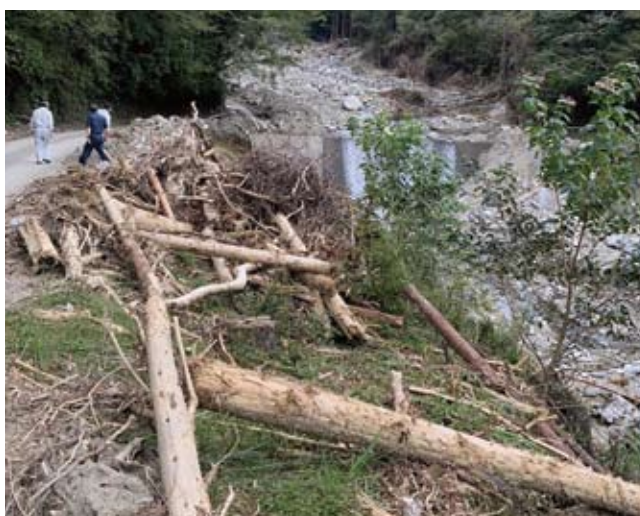
大規模山腹崩壊による村道臼杵又線の災害 (小崎・臼杵又地区)
