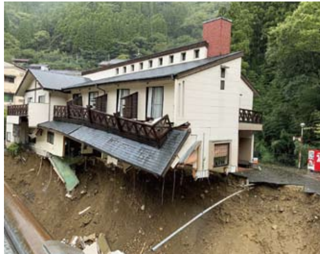
地盤がえぐられ、全壊状態の民宿「三越荘」(上椎葉地区)
