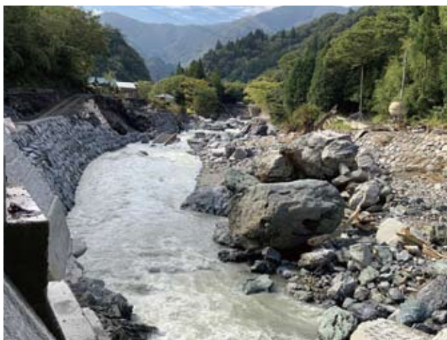
河川氾濫と破壊され流された橋(尾前・小原地区)
