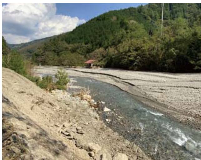
土石堆積による源流祭り会場の被害 (梶尾・吐野々地区)
