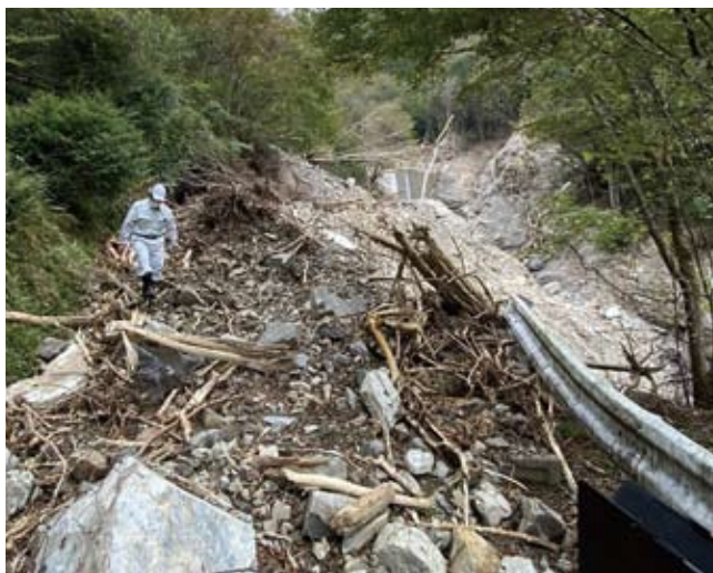
山腹崩壊による村道蛇ウト線の道路災害 (小崎・川の口地区)
