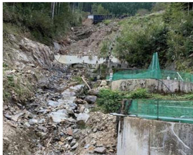
崩壊流入によるチョウザメ養殖施設の被害 (上椎葉・桑の木地区)
