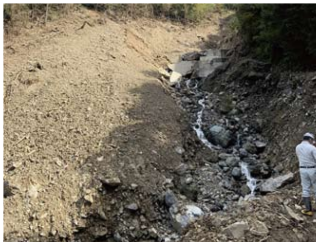
数基の砂防破壊が行われている(小原谷中腹)
