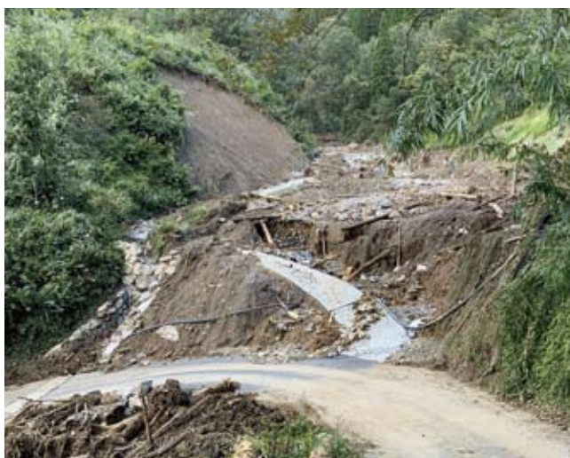
水無集落の土石流入による農地(田)滅失災害 (尾向・水無地区)
