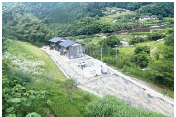
下水流公営住宅2棟目が完成、隣に議案78号の3棟目が建設される予定
