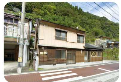
改修が完成したUIターンサポートセンター
