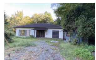
尾田山中住宅サブリース
