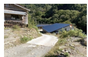
仮設道撤去工事
