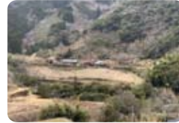
宅地造成と住宅新築工事
