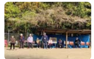
屋外ゲートボール場拡張工事
