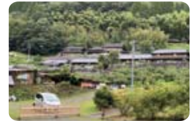
利根川伝建地区修景工事
