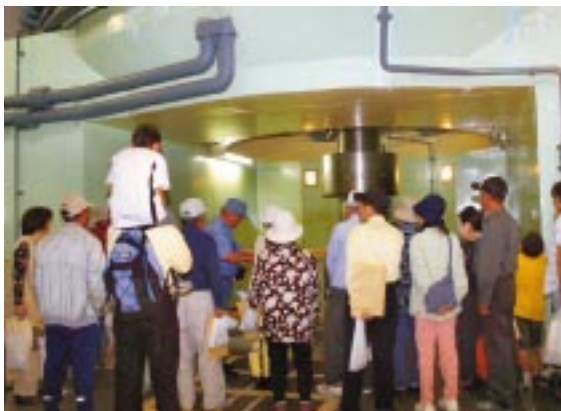
▲普段は見る事ができない上椎葉発電所の内部
