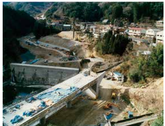
▲工事中の上椎葉バイパス (平成5年10月開通)
