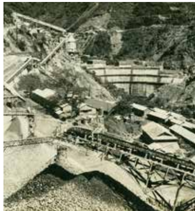
▲建設中の上椎葉ダム (昭和30年5月26日完成)
