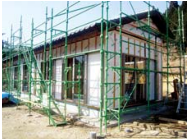
■建設当時の矢立地区山村定住住宅
