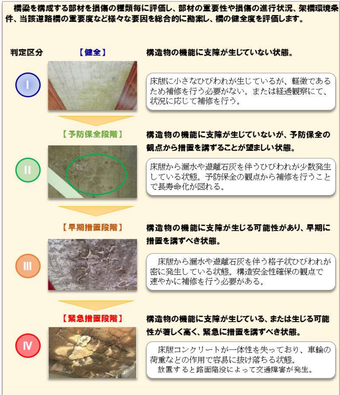
図3 橋の健全度の事例
