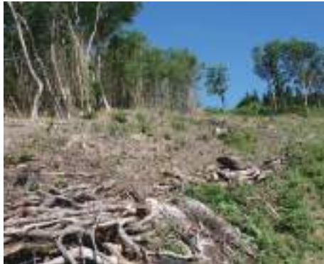
③ 伐った枝などは、集めて積んでおき、火入れの際に燃えやすくします。
