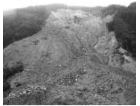
高塚山（大河内）の大規模な地滑りで林道が崩壊。
