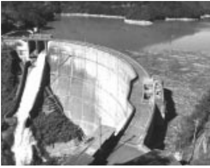
流木が浮く上椎葉ダム。下流にある発電所が運転停止となっているため、被災後も放流を続けている。
