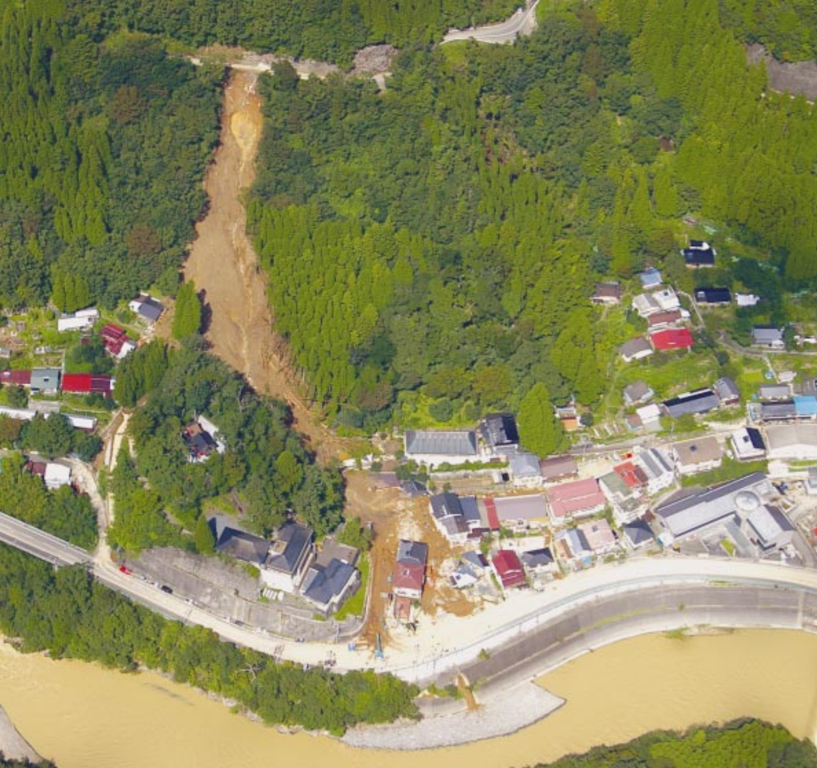
地滑りによる大量の土砂が家屋を押しつぶしながら、国道まで流出。(上椎葉上区)
