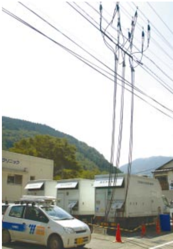
▶ 9月6日、浸水により上椎葉発電所が火災。現在も運転停止に。電気復旧のために九州各地から高電圧車などの作業班が集結。
