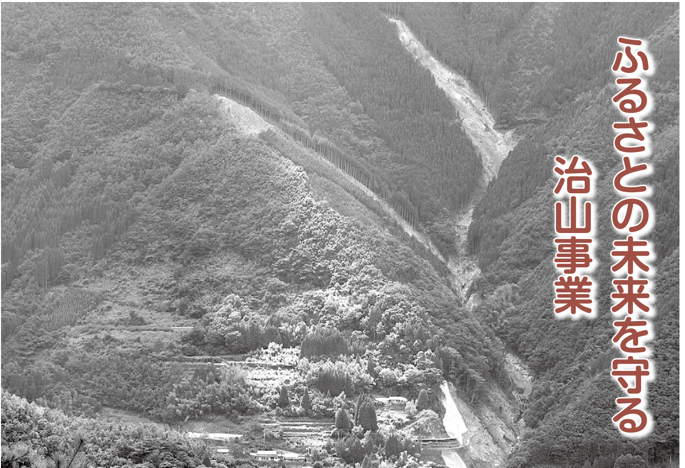
▲現在、治山事業を施工中の松尾地区（野地）山地災害箇所
