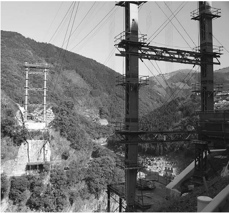
きょうりょう 橋梁工事が進む岩屋戸バイパス。国道327号線の上椎葉から諸塚村古園までは約30分ほどの道程で、そのほとんどがまだ一車線。改良にはどれだけの年月が掛かるのか見当もつきません。
